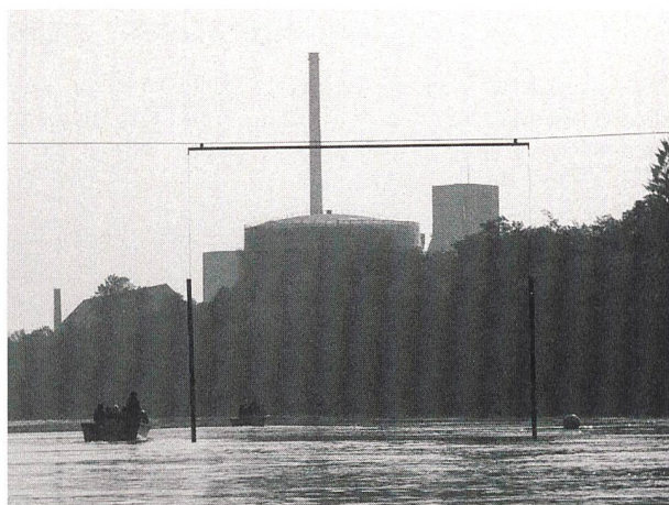
Die NOK gab im Geschäftsjahr 1996/97 im Versorgungsgebiet ihrer neun Besitzerkantone infolge des milden Winters 0,2 Mrd. kWh weniger ab als im Vorjahr. Im Bild das Kernkraftwerk Beznau der NOK.
