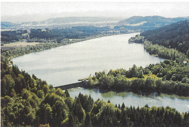
Die Wasserkraft soll in der Europäischen Union um 13 GW gesteigert werden (im Bild die Lechstufe 7 bei Finsterau/Bayern; Photo BAWAG).
