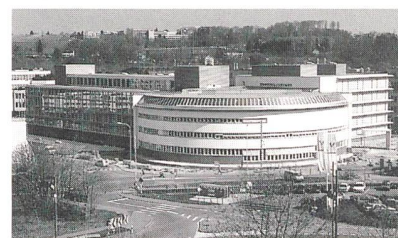
Bild 3 Solarstromanlage auf Büroneubau der Schweiz. Rückversicherung, Adliswil (Foto K. Heimberg).
