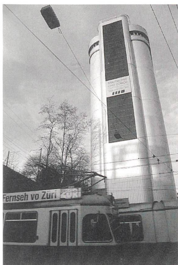
Bild 1 Solarstromanlage «Sirius», Zürich.
