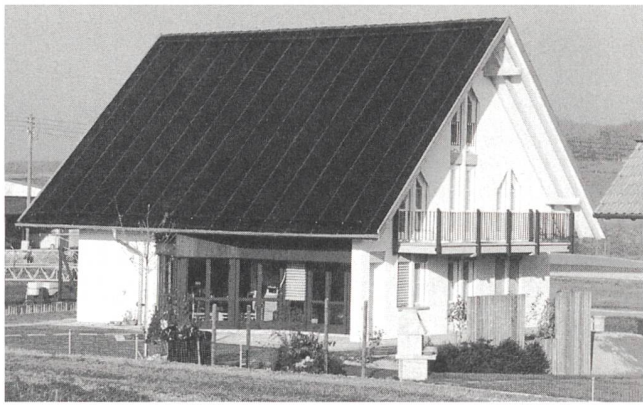
Solarwärmedach: vollständige Integration in die Dachfläche.
