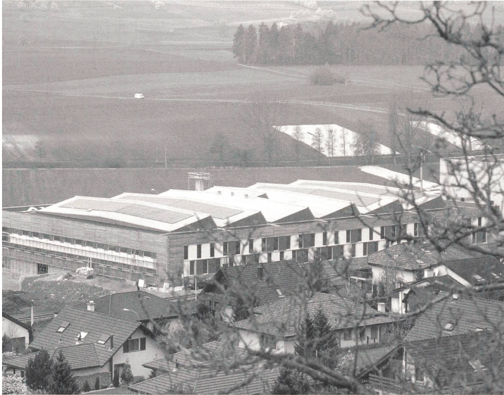
Gesamtansicht der 100-kW p -Photovoltaikanlage auf dem Trisa-Neubau 2000. Die Bürstenfabrik ist der grösste Solarstromlieferant der CKW.
