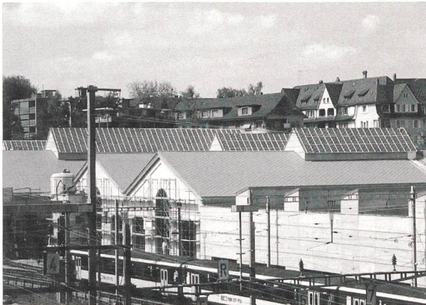
In der Oberlichtverglasung des SBB-Lokdepots wurde eine Photovoltaik realisiert. Im Endausbau liefert sie jährlich 53 000 kWh Strom, der in das Netz des EWB gespiesen und über die Ökostrom-Börse verkauft wird.
