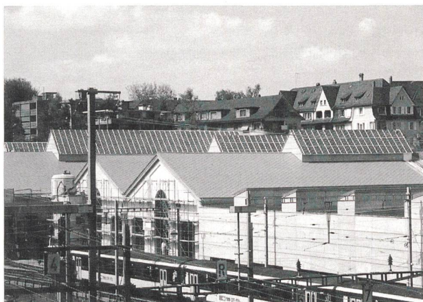
In der Oberlichtverglasung des SBB-Lokdepots wurde eine Photovoltaik realisiert. Im Endausbau liefert sie jährlich 53 000 kWh Strom, der in das Netz des EWB gespiesen und über die Ökostrom-Börse verkauft wird.
