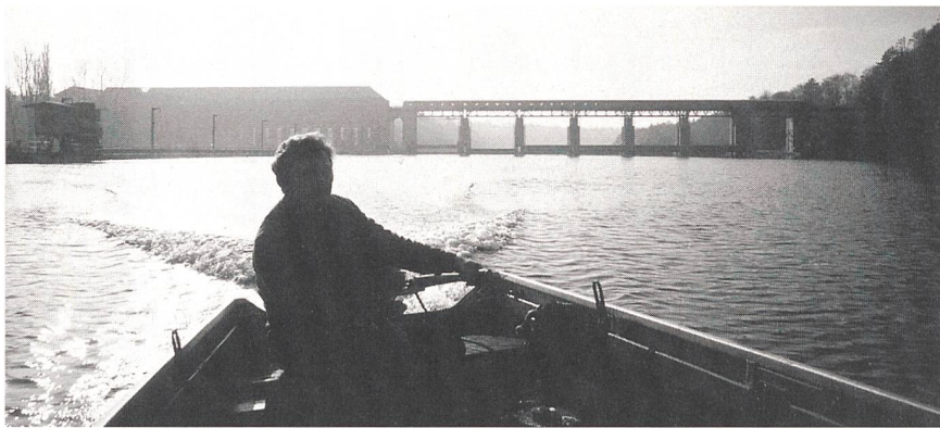
Die neue Konzession für das Kraftwerk Eglisau verpflichtet die NOK unter anderem dazu, insgesamt 14 Mio. Franken zugunsten von Umweltmassnahmen einzusetzen.
