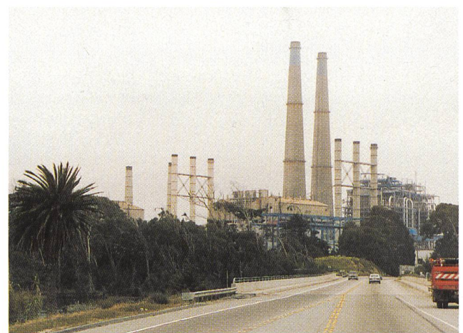
Bild 3 Gasturbinen-Kraftwerk mit angegliederter Prozesswärmenutzung südlich von San Francisco (Foto K. Niederau).
