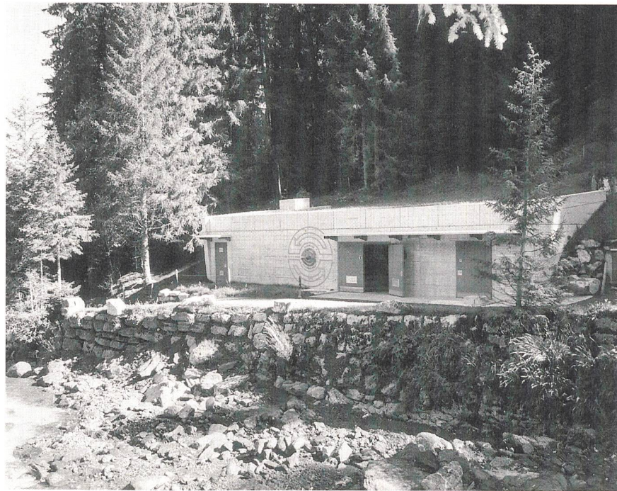
Die Zentrale Geissbrunnen im Saxettal: Das Trinkwasser aus den Quellen auf Alp Nessleren wird im Reservoir Stalden gesammelt und in einer 1. Stufe in der Zentrale turbinieren.
