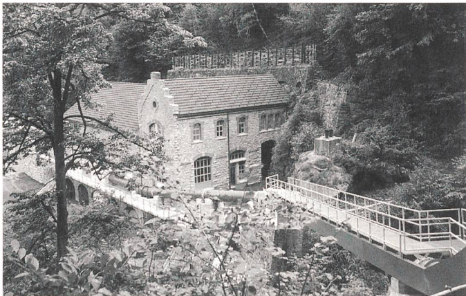
Die Fassaden des Gebäudes und die sich noch in gutem Zustand befindenden Innenteile des Kraftwerks Ticinetto sind erhalten und saniert worden. Die Gesamtkosten für die Erneuerung und Modernisierung beliefen sich auf etwa 8,6 Mio. Franken.
