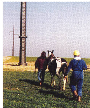
Bodenschonender Leitungsbau mit Jessy
