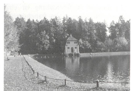
Ältestes Pumpspeicher-Kraftwerk der Schweiz (erstellt 1909): Engeweiher (SH).
