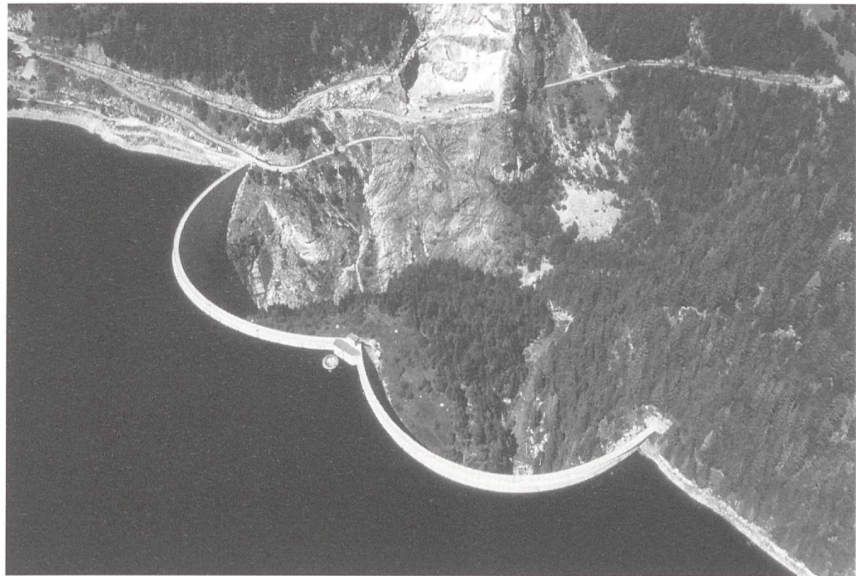
Stauanlage Hongrin (Veitaux-Hongrin, VD).
