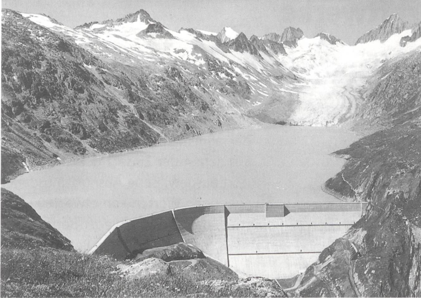
Stauanlage Oberaar des Pumpspeichersystems Grimsel (BE).
