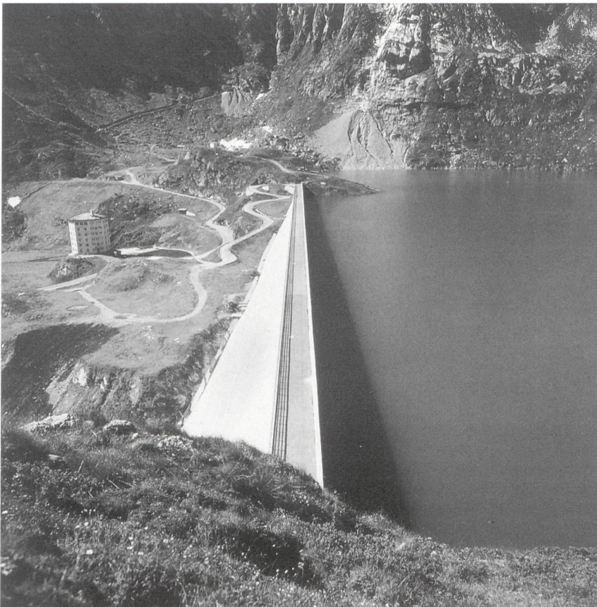
Pumpspeicheranlage Robiei (TI).
