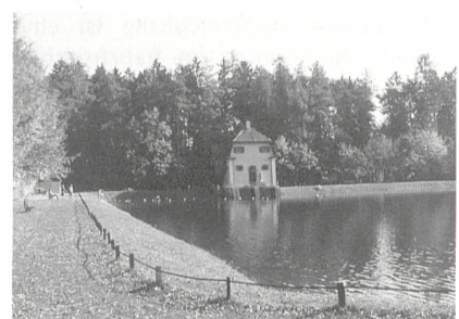
Ältestes Pumpspeicher-Kraftwerk der Schweiz (erstellt 1909): Engeweiher (SH).
