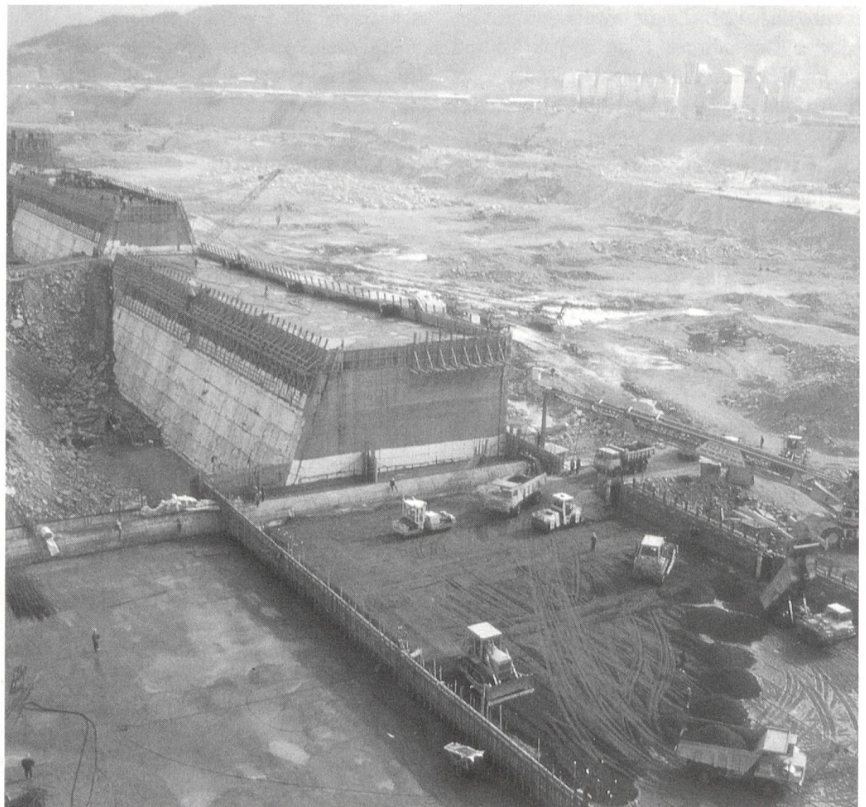
Bild 5 Betonierung des Kofferdamms.
