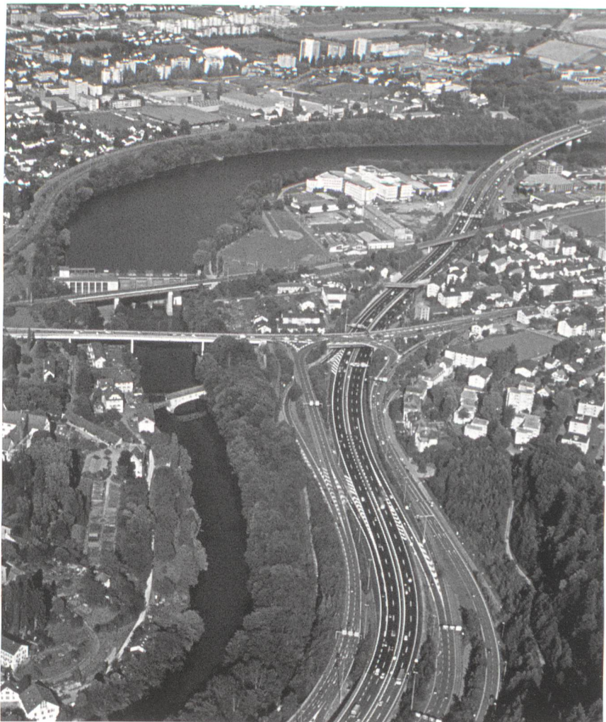
Das EWZ-Flusskraftwerk Wettingen liegt an der Limmat in dicht besiedeltem Gebiet zwischen den Gemeinden Wettingen und Neuenhof. Die rund 10 km lange Staustrecke ist ein beliebtes Naherholungsgebiet.
