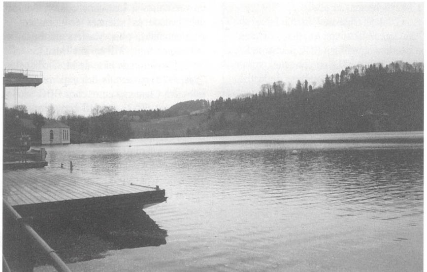
Der Wohlensee bei Mühleberg: Die BKW hat in den letzten 18 Monaten den Grundablass des bald 80jährigen Wasserkraftwerkes Mühleberg für 8,2 Mio. Franken saniert und modernisiert.
