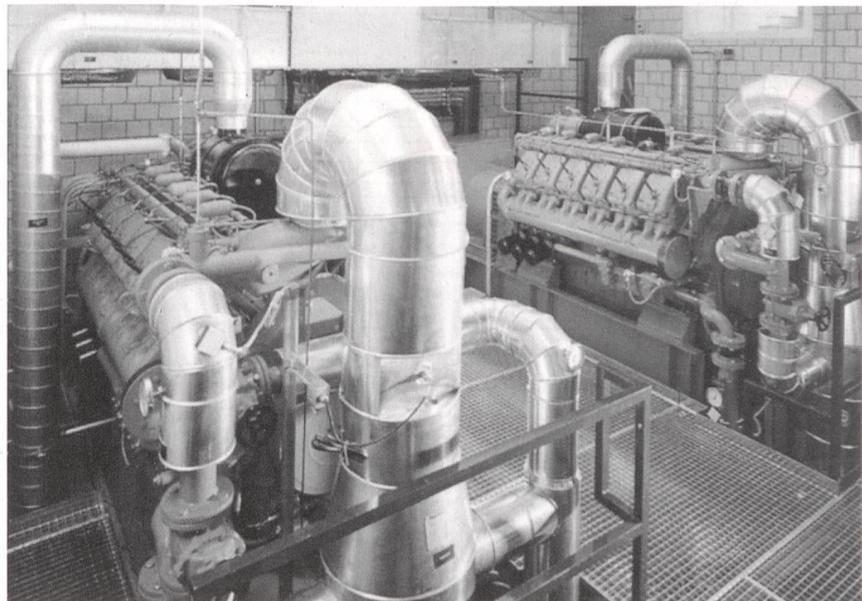
Bild 1 Blockheizkraftwerk-Anlage.
