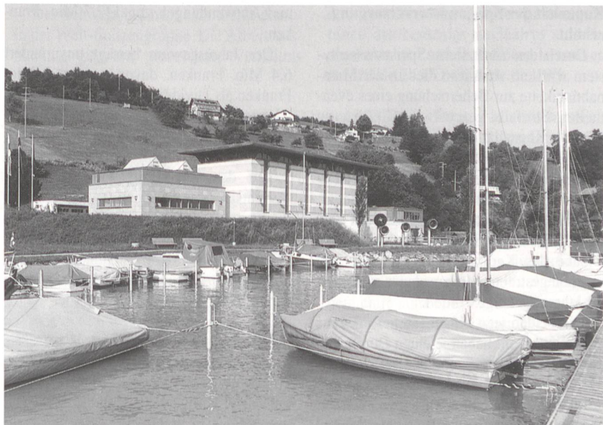
Im Wasserkraftwerk Spiez müssen Erosionsspuren an den Turbinenrädern behoben werden.
