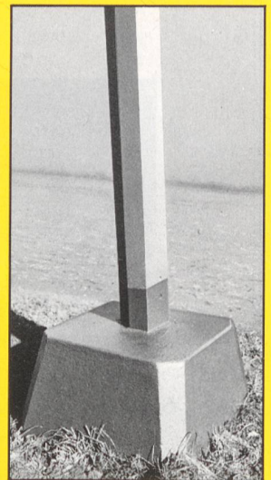
Betonschutz an Mastsockeln
