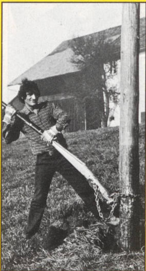
Nachimprägnierung von Holzmasten
