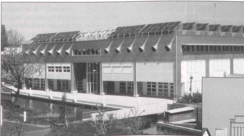
Bild 1 Ansicht auf das Gebäude der Abteilung Elektrotechnik der HTA Burgdorf mit dem Solargenerator (60 kW p ) der PV-Testanlage. Eine Eisenbahn-Hauptstrecke führt etwa 10 m hinter dem Aufnahmestandort durch.
