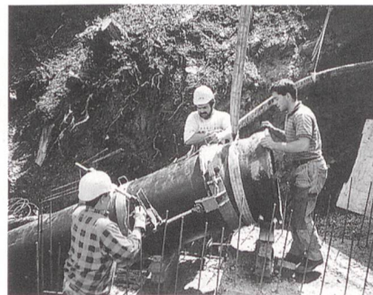
Bild 4 Das einfache Steckmuffensystem erlaubte die Montage der gusseisernen Druckleitung direkt durch den Bauunternehmer.
