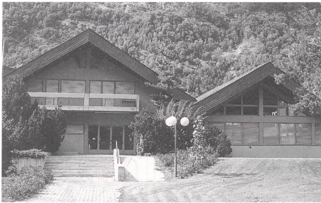
Schulhaus in Brig mit Grundwasser-Wärmepumpe (Bild fws/Beyeler).
