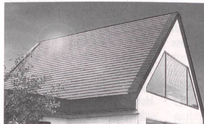
Das System vereint Dacheindeckung und Energiegewinnung (oben).
