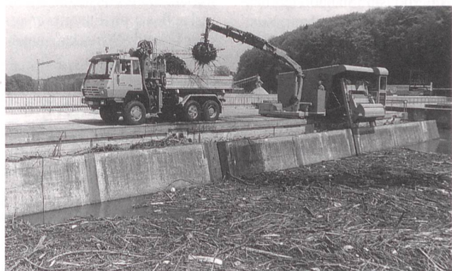
Viel Biomasse als Geschwemmel in Schweizer Flusskraftwerken.
