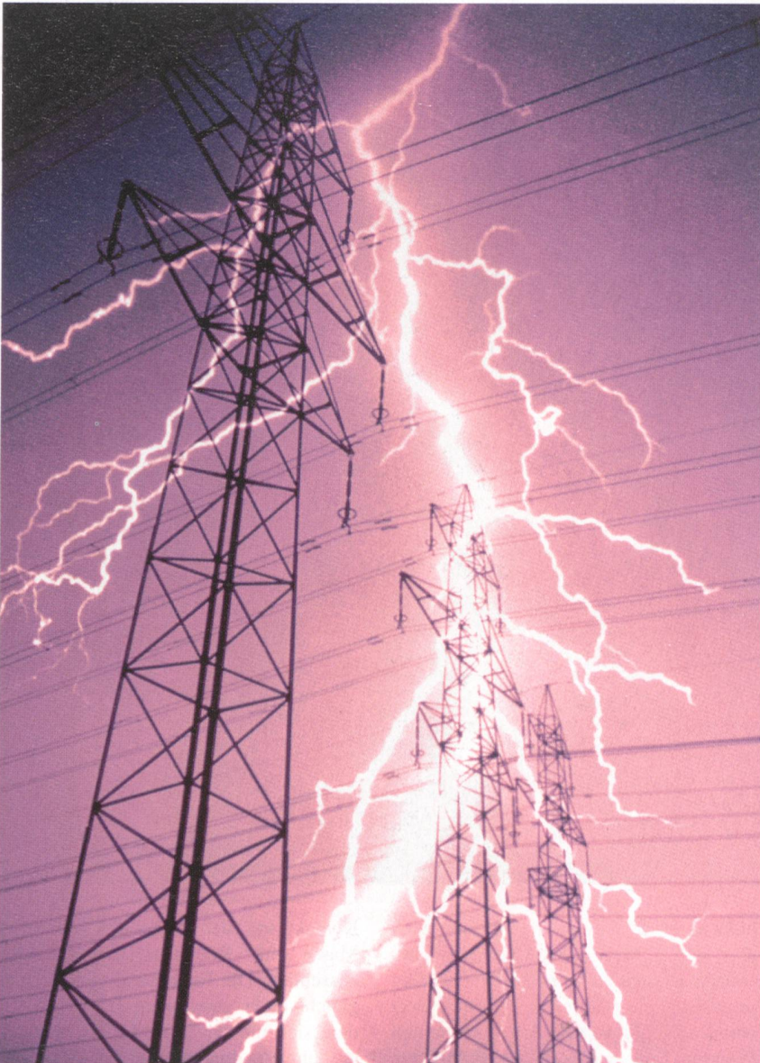
Dank frühzeitiger Kenntnis von Wetterauswirkungen können vorsorgliche technische und betriebswirtschaftliche Massnahmen im Kraftwerk- und im Leitungsbereich getroffen werden. Davon profitiert sowohl die Sicherheit der Stromversorgung als auch der möglichst ökonomische Kraftwerkbetrieb (Bild NOK).
