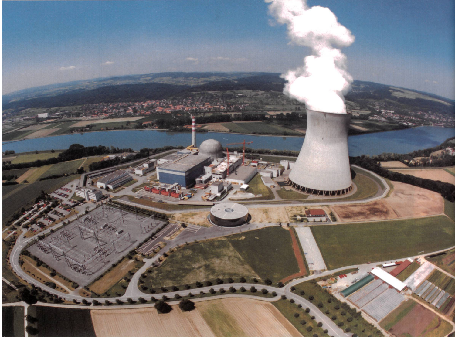
Leistungserhöhung für das Kernkraftwerk Leibstadt (AG).
