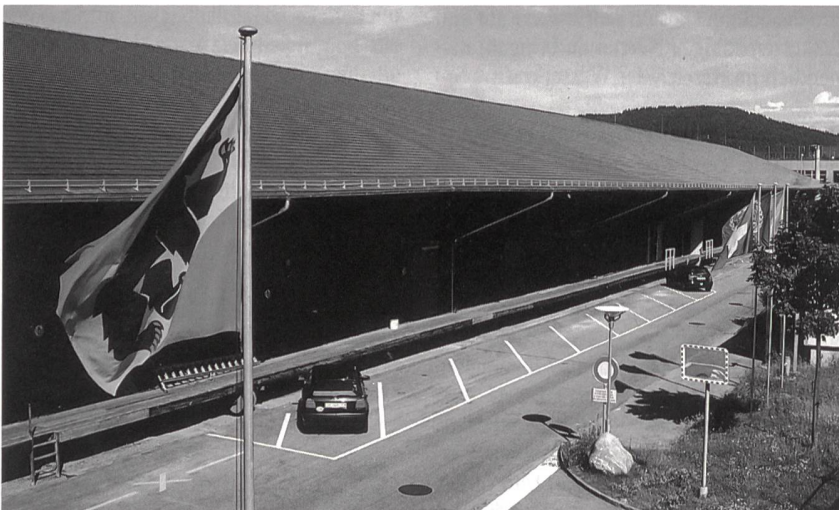
Das Solarziegeldach des eidgenössischen Getreidemagazins liefert Strom für die Berner Ökostrombörse.
