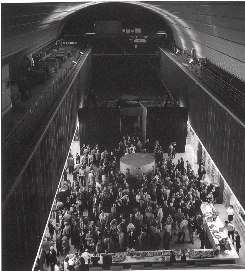
C'était le 4 juin 1999 qu'a été inaugurée officiellement la nouvelle centrale hydroélectrique de Bieudron. Quelque 400 invités ont participé à la manifestation officielle, parmi lesquels le conseiller fédéral Moritz Leuenberger et de nombreuses personnalités des milieux économique et politique.
