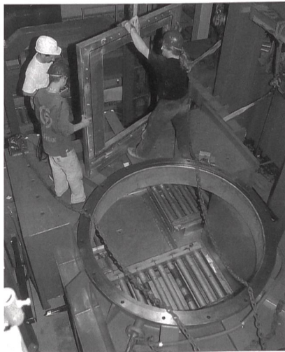
Der Plasma-Ofen wird montiert. Sein Lichtbogen kann neben brennbaren auch unbrennbare radioaktive Abfälle zersetzen und aufschmelzen.
