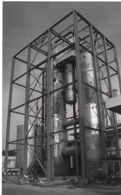
Bilder 1 bis 3 Bauphasen der Versuchsanlage PANDA. Das mechanische Grundgerüst für die Versuchsanlage PANDA bildet das Behältersystem. Zylindrische Druckbehälter (10 bar/200°C) stellen Reaktordruckbehälter und Sicherheitsbehälter einer Reaktoranlage dar. Ganz oben sind die kubischen Kühlbecken für die passive Nachwärmeabfuhr zu sehen. Um die Behälteranlage herum wurde eine Stahlbaute errichtet.
