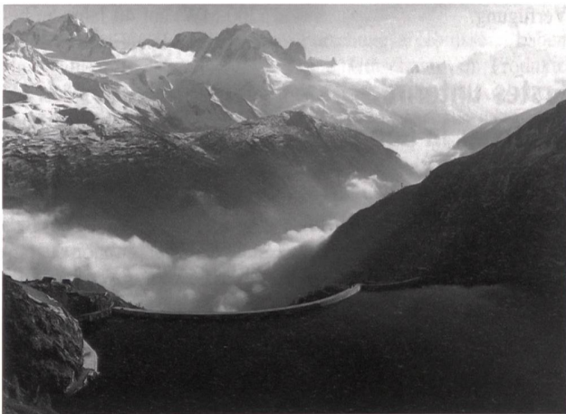
Staumauer Emosson: Messprogramm abgeschlossen.
