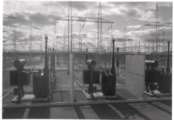
Milliardenschäden auf nördlichen Stromnetzen? (800-kV-Unterwerk in Kanada).
