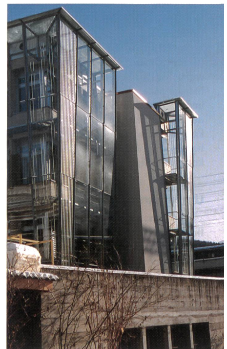
Bild 3 Eckdetails der Glasfassade mit Vogelschutzstreifen
