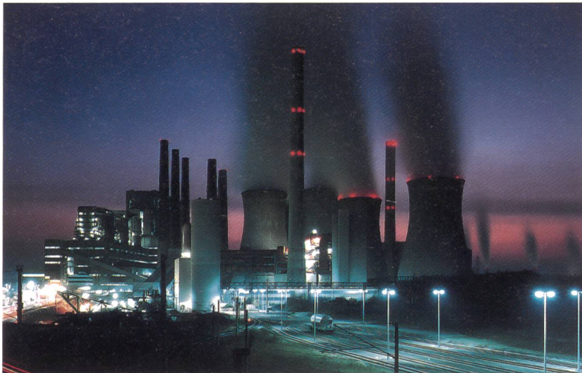
Der deutsche Kraftwerkspark wird durch Stein- und Braunkohlekraftwerke (53% Produktionsanteil) dominiert (im Bild Kraftwerk Neurath; Photo RWE).
