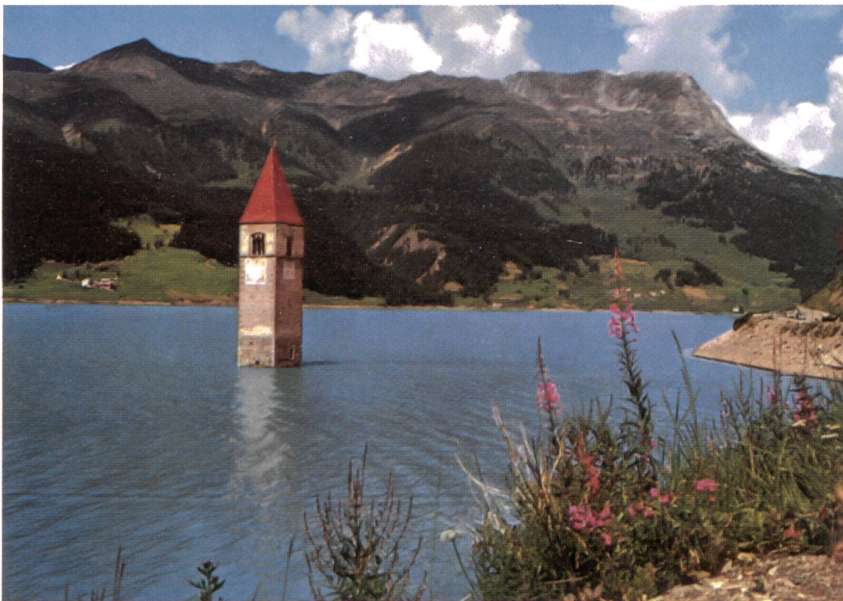
Italien: Rund 18% der Produktion durch Wasserkraft (hier der gestaute Reschensee im Südtirol, nahe der Schweizer Grenze, mit dem berühmten Vinschgau-Turm).
