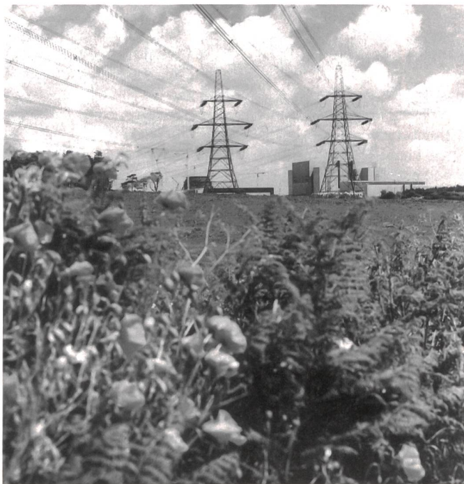
Kernkraftwerk Sizewell (Grossbritannien; Photo National Grid).
