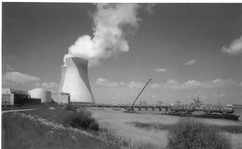
Kernkraftwerk Doel (Belgien; Bild Electabel).
