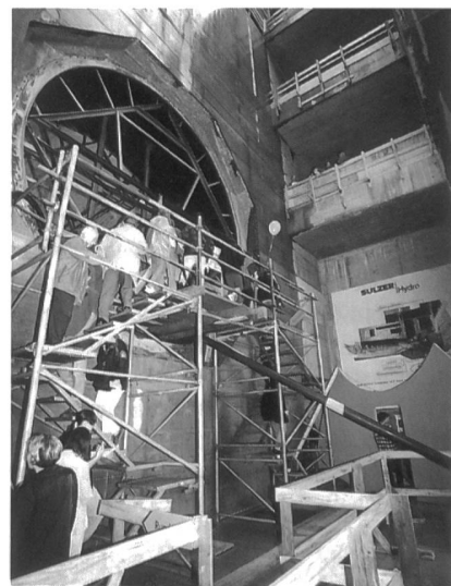
Am Tag der offenen Tür konnte der Rohbau besichtigt werden. 5,9 Meter misst die Öffnung für das Turbinenrad.
