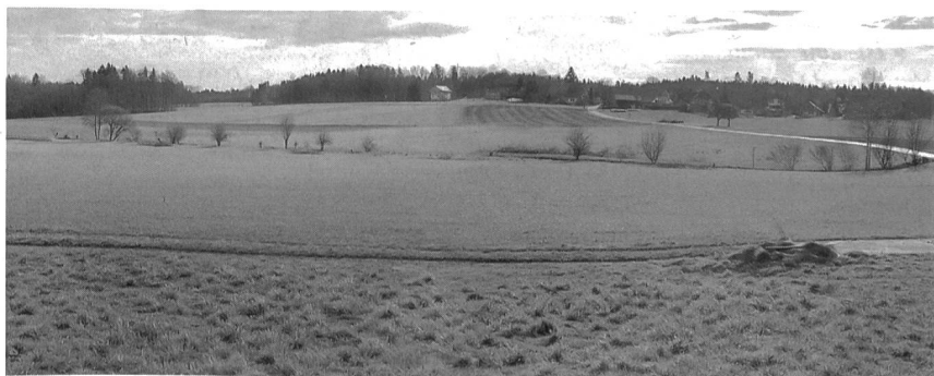
Bild 4 Fallbeispiel Bahn 2000: Die von der neuen Eisenbahnlinie betroffene Landschaftskammer Hersiwil soll mit einer Tunnelverlängerung besser geschützt werden. (Bild: G. Roth)
