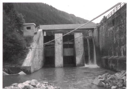
Umgebautes Wehr Burvagn: Ansicht von der Unterwasserseite.
