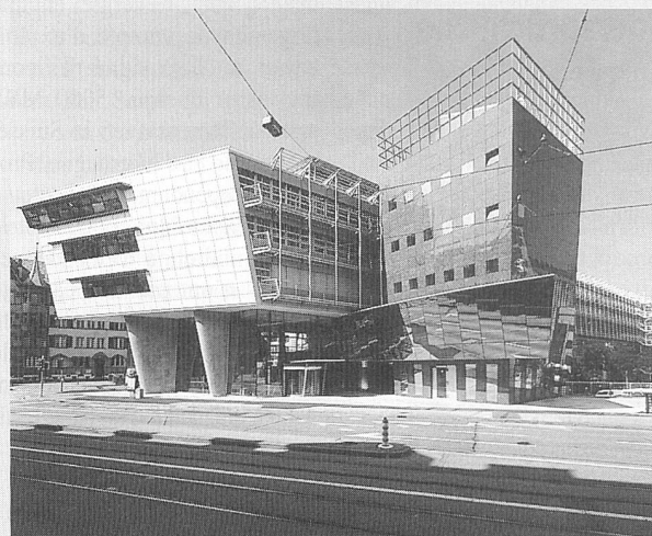
Im kommenden Jahr soll Titanic II ausschliesslich durch die Nutzung erneuerbarer Wärmequellen und Abwärme beheizt werden.
