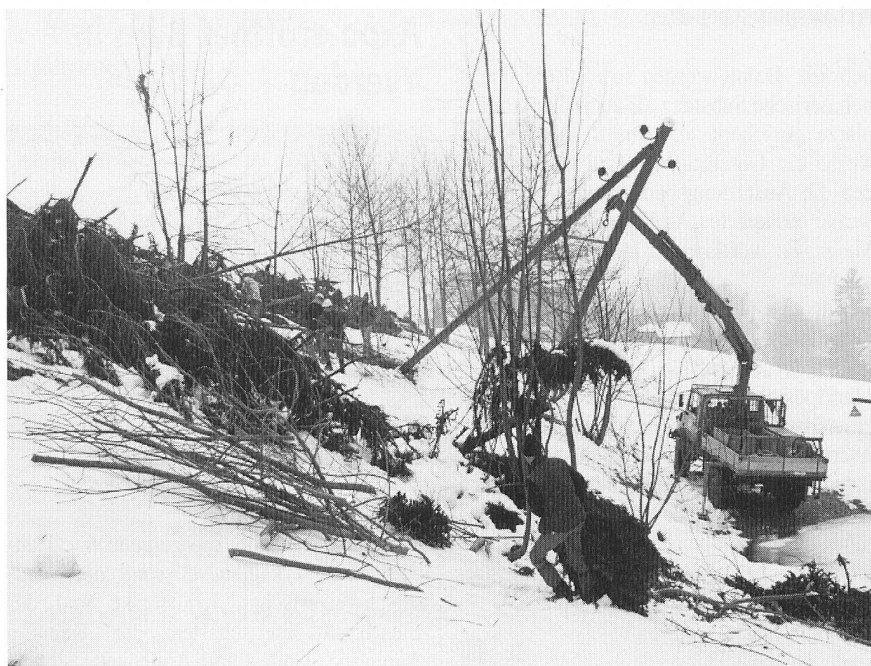
Aufräum- und Reparaturarbeiten am EKZ-Netz nach dem Sturm Lothar.
