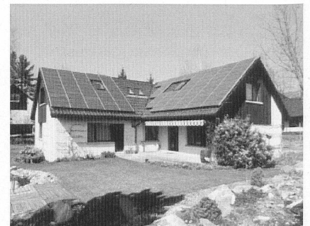
Photovoltaikanlage auf Einfamilienhaus in Nürensdorf.
