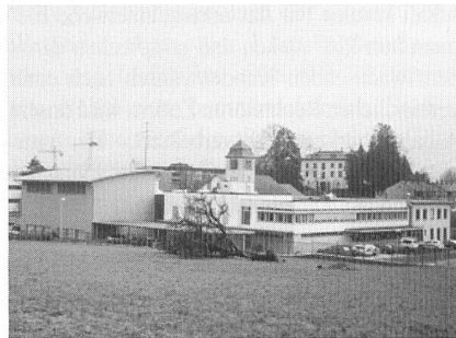
Das Joner EW-Areal: Im Anbau (links) befindet sich das neue Unterwerk.
