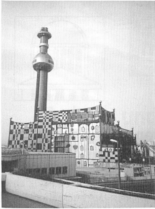
Fernwärmewerk Spittelau in Wien, gebaut 1992 nach den Plänen von Hundertwasser.
