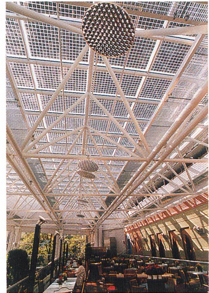
1999 gingen in der Schweiz rund 120 neue PV-Anlagen ans Netz (im Bild Anlage Migros Limmatplatz/Zürich; Photo energiebüro/Peter Eichenberger).
