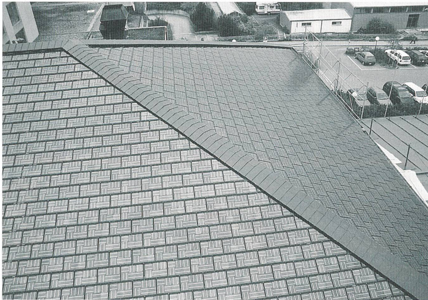
Bild 2 Dreieckförmige Ostseite des Solarschieferdachs des Spitals Burgdorf mit allseitig perfekten Randabschlüssen.
