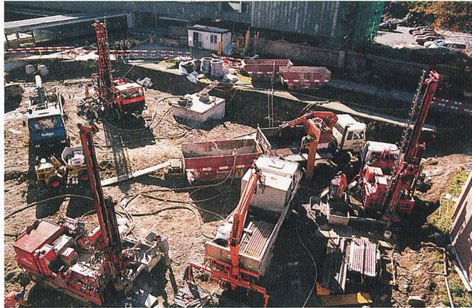
Bild 6 Verlegte Zuleitungen zu den Erdwärmesonden bzw. zum Sammel-schacht. Aufnahme vom 28 m hohen Turm des Eidgenössischen Amtes für Messwesen.
