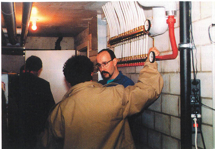
Bild 3 Heizkreisverteiler.
