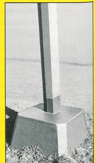
Betonschutz an Mastsockeln
