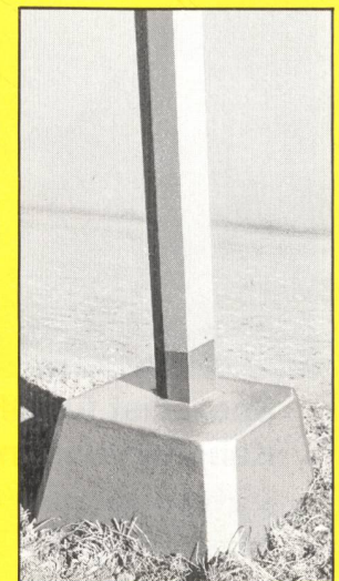
Betonschutz an Mastsockeln
