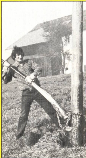
Nachimprägnierung von Holzmasten
