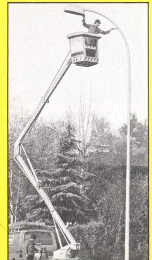
Korrosionsschutz an Stahlkandelabern
