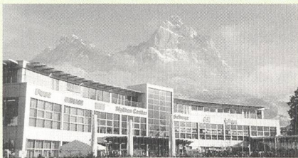
Einkaufszentrum Mythen-Center Schwyz: Gesamtplanung der elektrischen Anlagen durch Elektro-Planung R. Mettler AG
