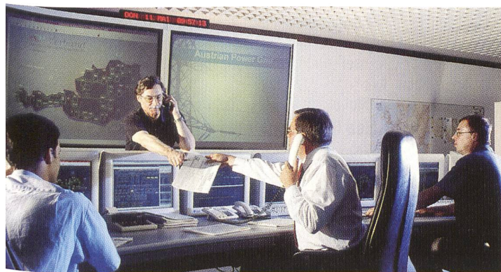
Österreichs «Stromleitzentrale» in Wien-Südost steuert das überregionale Hochspannungsnetz (Bild Verbund).
