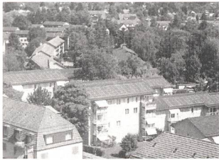
Solrif-Dachintegration mit BP-Solar-Modulen auf Mehrfamilienhäusern
