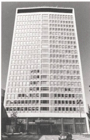
Zentrale der RWE Plus AG in Essen.
