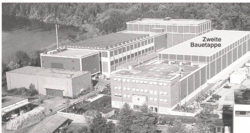
Die neuen Lagerhallen der ZWILAG in Würenlingen kurz nach der Fertigstellung.
