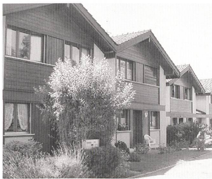
Bild 1 Die Hauseigentümer am Chemin des Pluviers bei Genf reduzierten ihre jährliche Stromrechnung mit dem Wechsel von dezentralen Elektroheizgeräten zur Wärmepumpenheizung um 2000 bis 3000 Franken. (Quelle: SIG)
