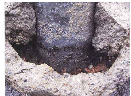
Bild 2 Freigelegter Korrosionsangriff im Erdeintrittsbereich.
