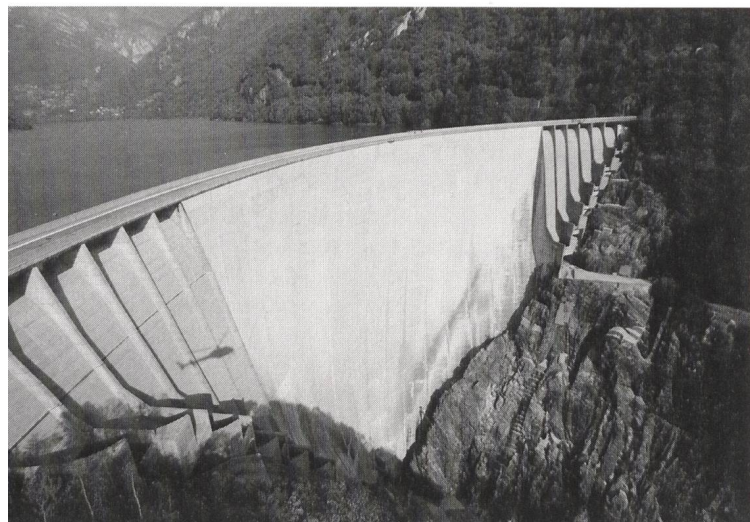
Staudämme und KKW-Anlagen verbleiben auf der höchsten Sicherheitsstufe.
